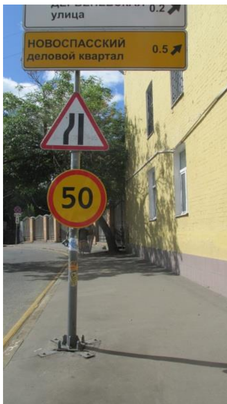
Рисунок 101 — Выступающее препятствие на уровне лица в зоне пешеходного движения
