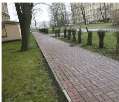
Рисунок 23 — Бортовой камень вдоль газона высотой не менее 5 см, обеспечивающий направляющую функцию для людей с белой тростью. Использование дренажной решетки в качестве направляющей для незрячих пешеходов
