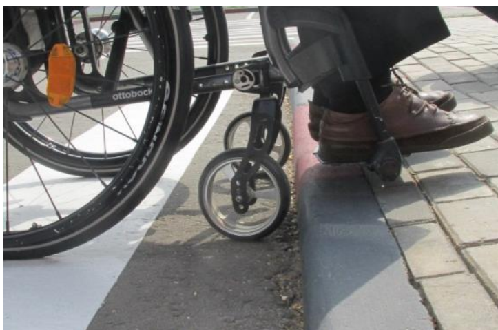
Рисунок 55 — Перепад высоты затрудняет движение инвалида на кресле-коляске
