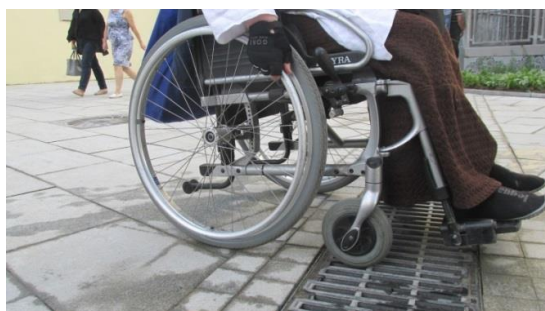
Рисунок 46 — Возможно застревание колес в продольных отверстиях решетки
