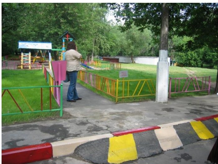
Рисунок 64 — Недопустимо размещать бордюрный пандус на проезжей части
