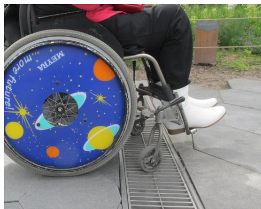
Рисунок 28 — Открытый водоотводящий лоток и широкие ячейки решетки представляют опасность
