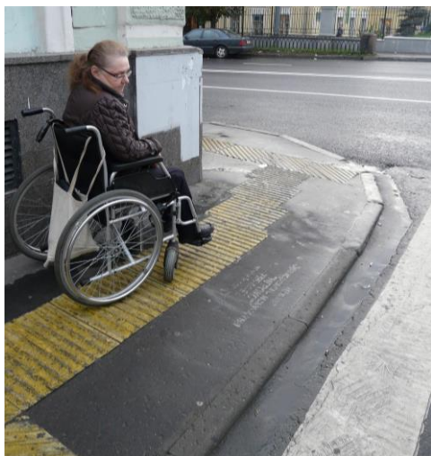
Рисунок 9 — Недопустимые уклоны на тротуарах
