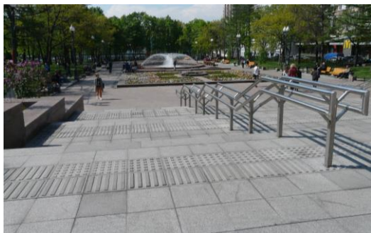
Рисунок 40 — Примеры тактильных указателей и контрастной маркировки лестничных маршей
