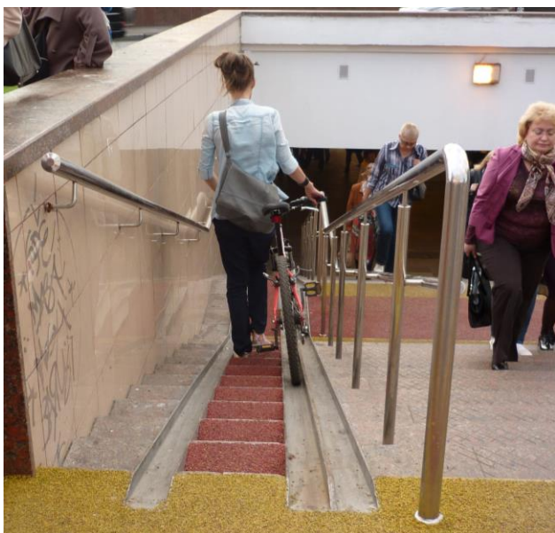
Рисунок 90 — Перемещение людей по накладным конструкциям на лестницы запрещено
