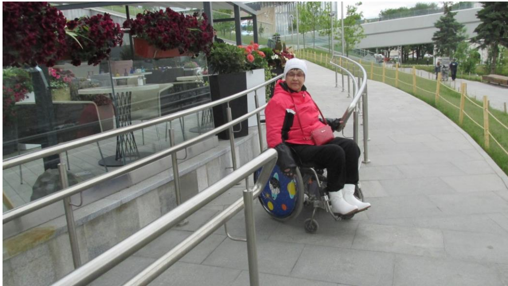
Рисунок 48 — Разрыв поручней на длинных пандусах
