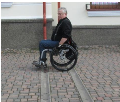
Рисунок 28 — Открытый водоотводящий лоток и широкие ячейки решетки представляют опасность
