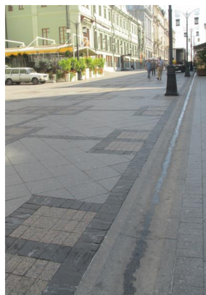
Рисунок 29 — Безопасные открытые лотки более пригодны для обустройства доступных путей движения
