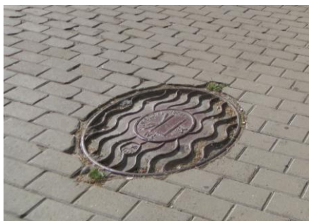
Рисунок 31 — Крышки люков, опасные для инвалидов
