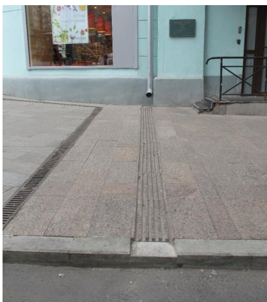
Рисунок 29 — Безопасные открытые лотки более пригодны для обустройства доступных путей движения
