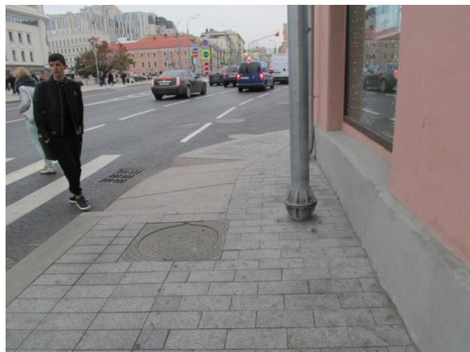
Рисунок 9 — Недопустимые уклоны на тротуарах
