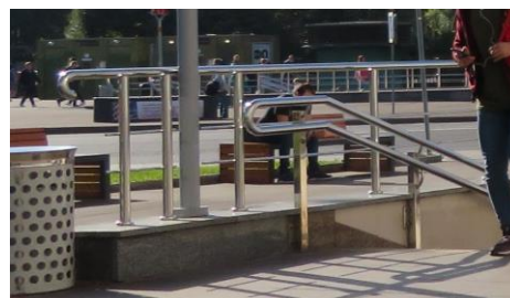
Рисунок 85 — Горизонтальные завершения поручней на лестничных сходах
