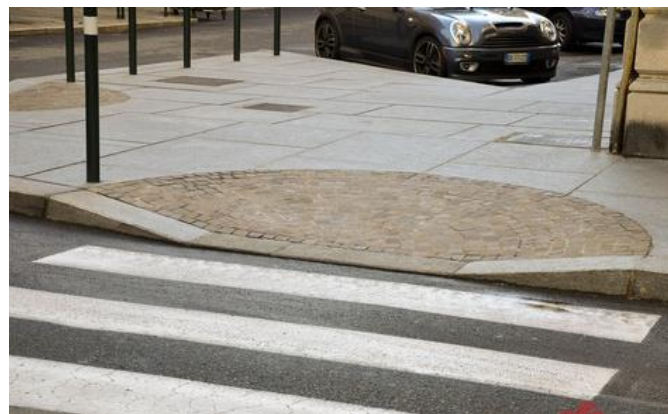
Рисунок 78 — Изменение характера мощения на бордюрных пандусах и местных проездах заменяет тактильные указатели
