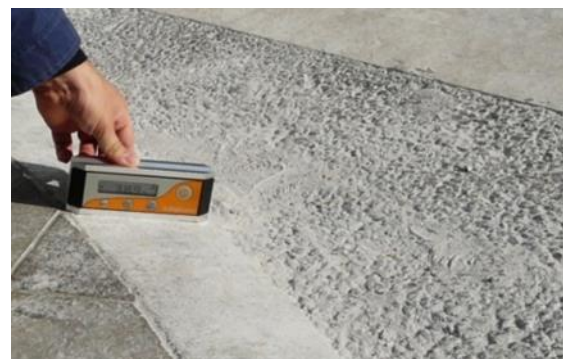
Рисунок 61 — Снята фаска бортового камня, уклон 40^\circ - недопустимо
