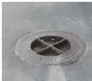
Рисунок 31 — Крышки люков, опасные для инвалидов
