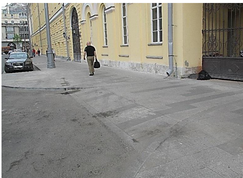
Рисунок 69 — Выезды из дворов расположены на одном уровне с тротуаром
