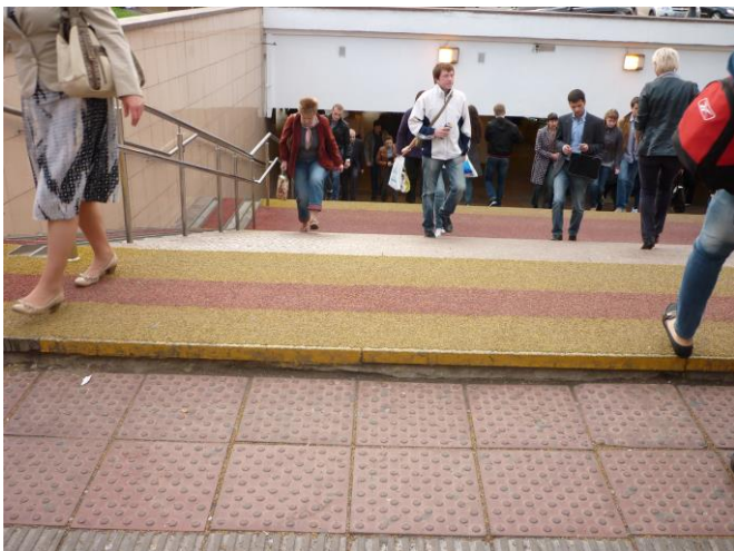
Рисунок 83 — Примеры контрастной маркировки ступеней лестничных сходов
