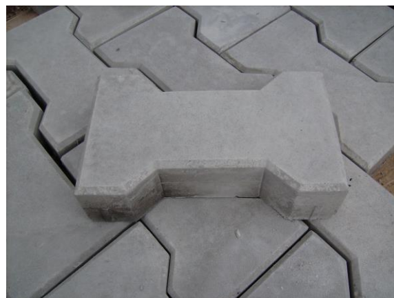
Рисунок 19 — Плитка «Бехатон», по которой некомфортно передвигаться на кресле-коляске
