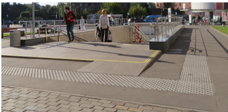
Рисунок 87 — Тактильные наземные указатели перед лестничными сходами
