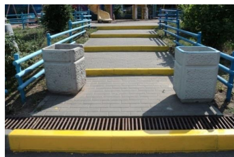
Рисунок 46 — Возможно застревание колес в продольных отверстиях решетки
