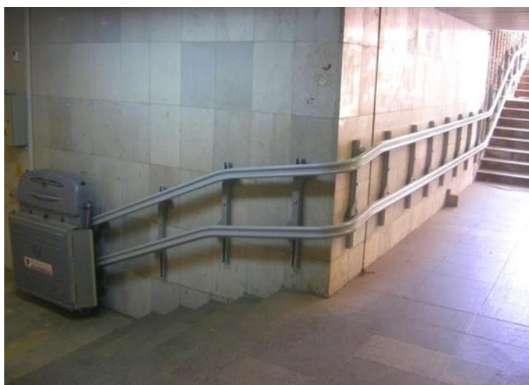
Рисунок 93 — Платформа наклонная в подземном переходе – запрещена к применению в СП 59.13330.2016 (изменение № 1)
