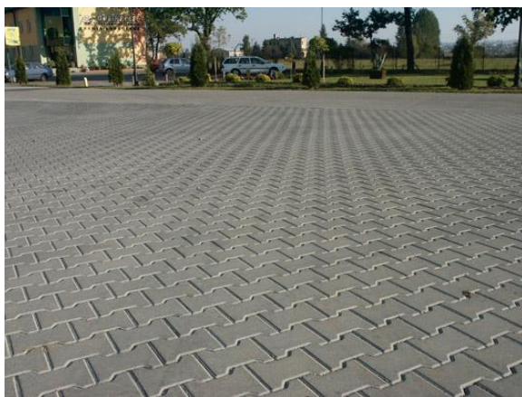
Рисунок 19 — Плитка «Бехатон», по которой некомфортно передвигаться на кресле-коляске
