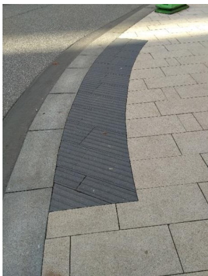
Рисунок 75 — Тактильные направляющие «под углом» задают направление перехода
