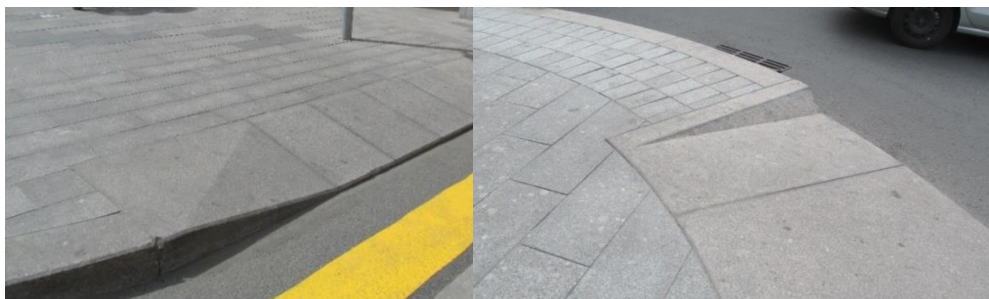
Рисунок 56 — Бордюрные пандусы со скошенными боковыми гранями
